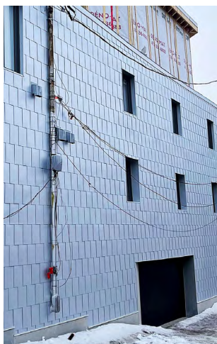
INSTALLATION AU MUR
