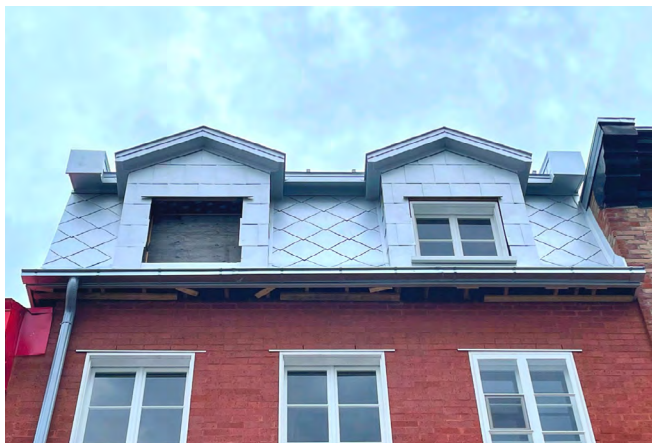
INSTALLATION AU TOIT
